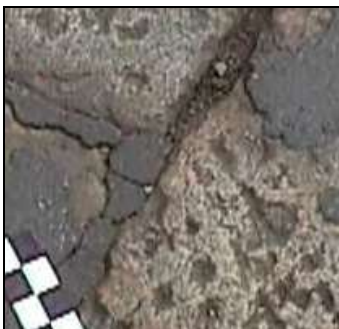
Figura 13: Asportazione di sigillante dai giunti
