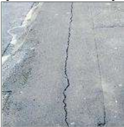
Figura 7: Schema di fessurazione longitudinale
